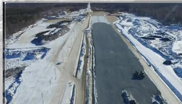
Строительство ВПП аэропорта космодрома «Восточный»
